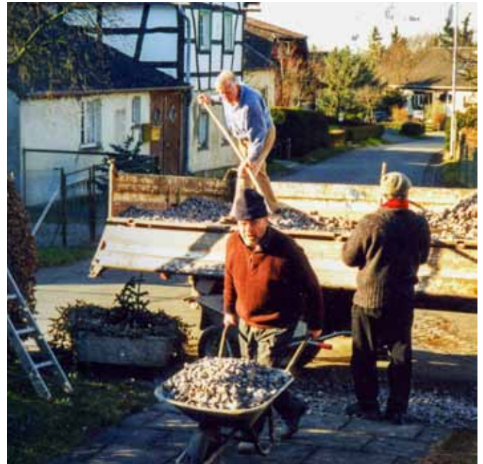
Die Restaurierung beginnt (Schotter für die Unterfütterung des Altarraums).
