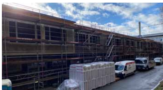
Schulzentrum Schleiden: Das Dach der Aufstockung in Verbindung der Turnhalle und der Grundschule wurde fertiggestellt, nun beginnt der Innenausbau. (© Stadt Schleiden/Felix Stoff)
