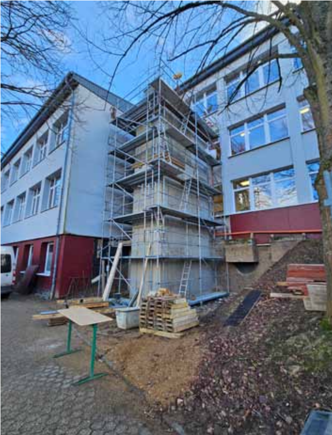
Der Bau der Aufzugsanlage befindet sich aktuell im Rohbau. (© Stadt Schleiden / Daniel Schwarzer)
