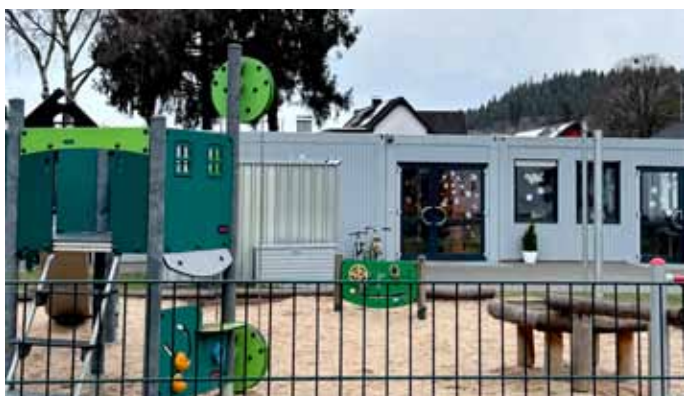
Die Kinder der Kita Oberhausen sollen Anfang 2026 in die Kita-Container in Olef ziehen. Im Anschluss daran wird die Anlage in Oberhausen abgebaut.
