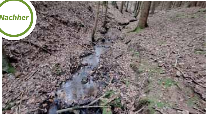
Tränkelbach Nierfeld: Die Tiefenerosionen wurden beseitigt. Es wurde ein Querriegel zum Geschiebefang eingebaut und die Breitenerosion als natürlicher Rückhalteraum belassen.
