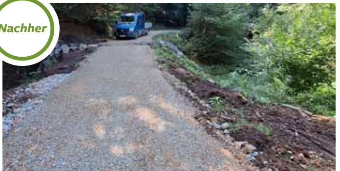
Delenbach: Der Weg wurde wieder aufgebaut und der Rückhalteraum wieder hergestellt (ausgebaggert). Zudem wurde eine Furt auf dem Weg angelegt, so dass im Falle einer Überlastung das Wasser abgeführt werden kann, ohne den Weg zu zerstören.
