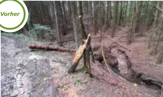
Tränkelbach Nierfeld: Starke Tiefen- und Breitenerosion die Bäume entwurzelt hat.
