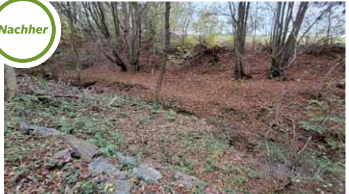
Tränkelbach Nierfeld: Der Weg wurde neu aufgebaut und gegen erneute Erosion mit Hilfe eines naturnahen Uferverbau bestehend aus Wasserbausteinen gesichert.
