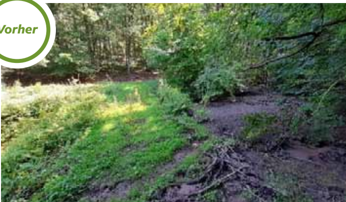
Delenbach: Der natürliche Rückhalteraum verlandete und der Weg wurde durch den Starkregen zerstört.
