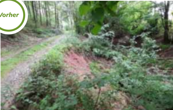
Tränkelbach Nierfeld: Ufererosion die den Weg unterhöhlt hat.
