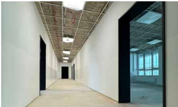
Im Schulverwaltungstrakt wurden bereits die Türzargen eingebaut und die Wände fertiggestellt; Böden und Decke werden in Kürze ausgeführt. (© Stadt Schleiden / Kerstin Wielspütz)
